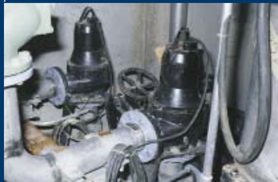
Vertikalno montirane crpke s hlađenjem preko odvodnika topline iz kućišta
