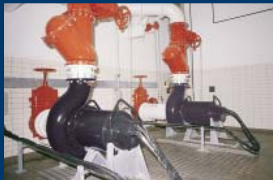
Horizontalno montirane crpke s rashladnim plaštem
