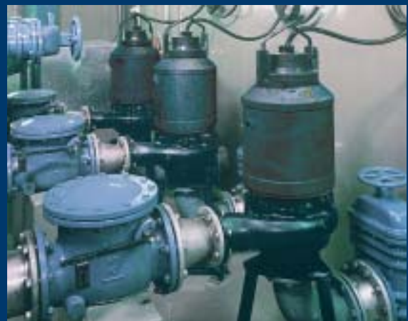
Vertikalno montirane crpke s rashladnim plaštem
