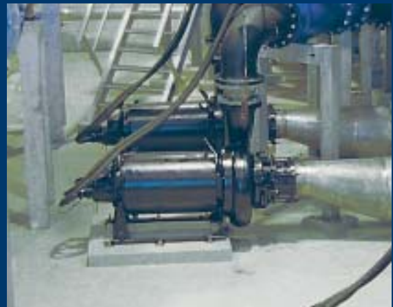
Horizontalno montirane crpke s rashladnim plaštem
